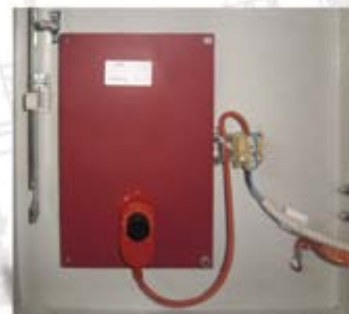
ΑΝΤΙΣΤΑΣΗ ΓΙΑ ΣΥΜΠΥΚΝΩΜΑΤΑ ΣΤΟΝ ΧΩΡΟ 20kV
